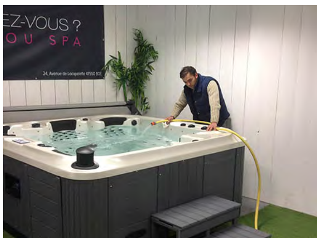
Mise en eau
